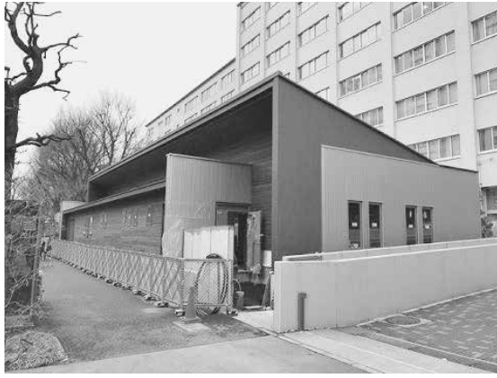
(農林水産省中央合同庁舎第1号館 南別棟)
